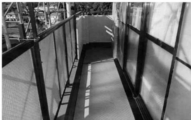
バルコニーの床・側溝：長尺塩ビシート+ウレタン塗膜防水
