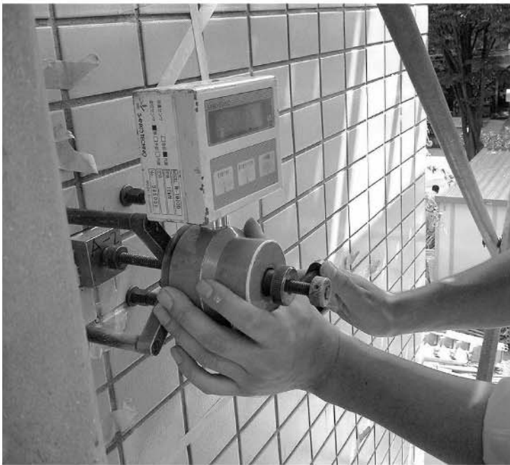
タイル接着力試験
