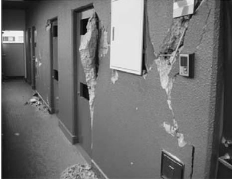
廊下の壁にX字型の亀裂
