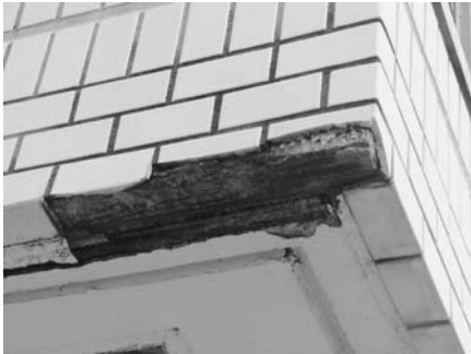
写真一 ベランダ下の鉄筋が錆びてコンクリートが爆裂
