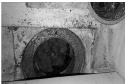
占有部分トラップが腐食、連結共用部分の腐食も疑われる
