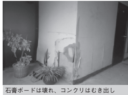
最上階5階の部屋、屋上からの漏水が原因で天井落下
