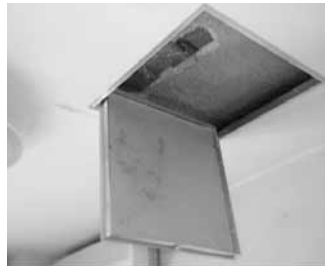
写真① 漏水箇所室内天井屋上部分補修跡
