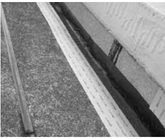
写真③ 屋上部分補修跡
