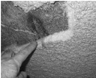
写真② 室内漏水箇所
